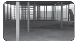
1F フェンダーヤード
