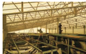
5月に完成したテントの大屋根
